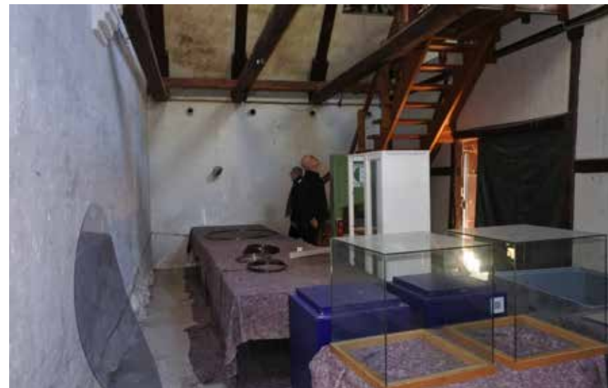
Bygningen bruges i dag til opbevaring og depot
